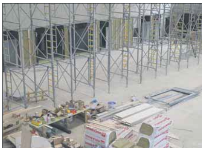
Noch im Bau: Die 2-Feldhalle
